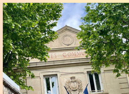
Les travaux de rénovation énergétique se poursuivront à l'école élémentaire.
