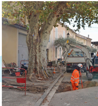
Des travaux sur le réseau d'eau sont menés pour remplacer tous les vieux branchements en plomb.
